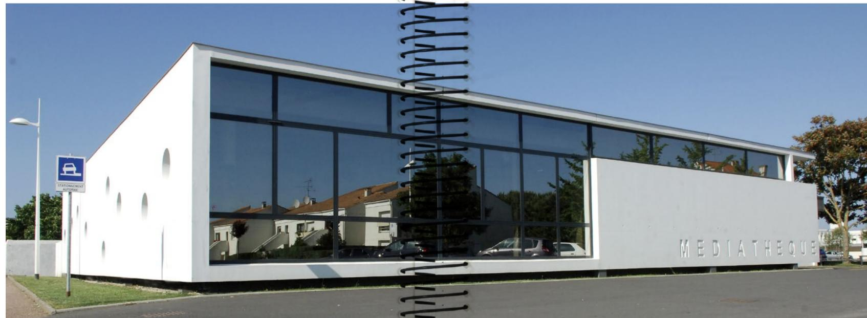
Le bâtiment existant, dont la volumétrie générale est conservée, abritera principalement les archives de la commune. Ses façades seront recomposées, entre sa structure béton, par des remplissages maçonnés percés. Une entrée indépendante est prévue en façade ouest pour le public venant consulter le pôle archives.
